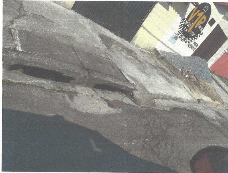
Foto de um dos bueiros no local
